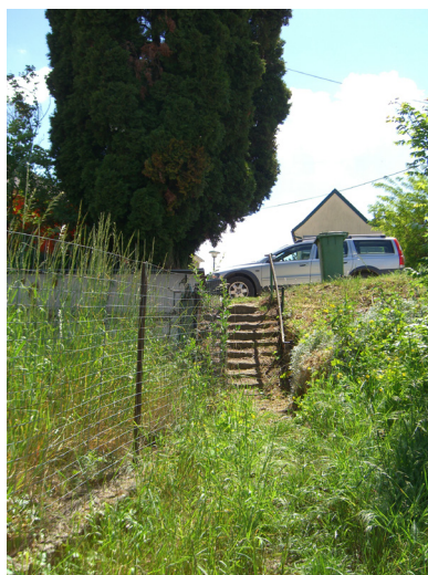
Bindergassl vor Sanierung
