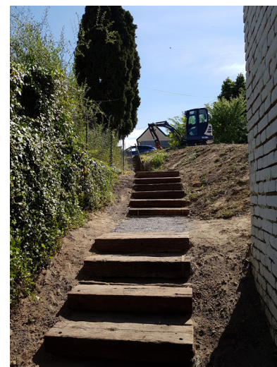
Bindergassl nach Sanierung
